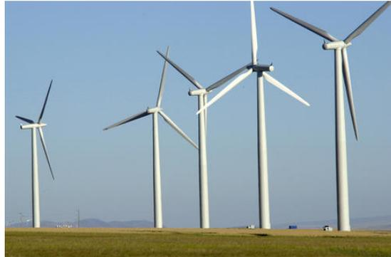
Fig. 3 Horizontal-axis turbines
